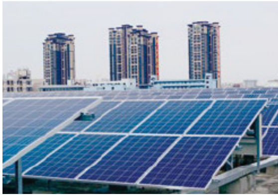
工場屋根に取り付けられた太陽光発電パネル群 コニカミノルタビジネステクノロジーズ（東莞）社
